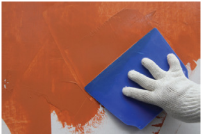
Cat Basecoat Aplikasikan ke seluruh bidang yang akan dicat, menggunakan kape plastik untuk menutup warna cat dasar.
