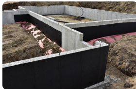
Dinding bagian luar basement
